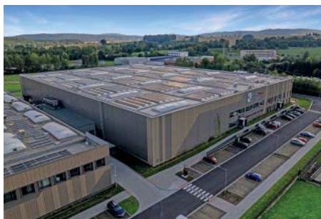
K dosud největším střešním solárním elektrárnám patří areál Urbanity Campus Tachov.
