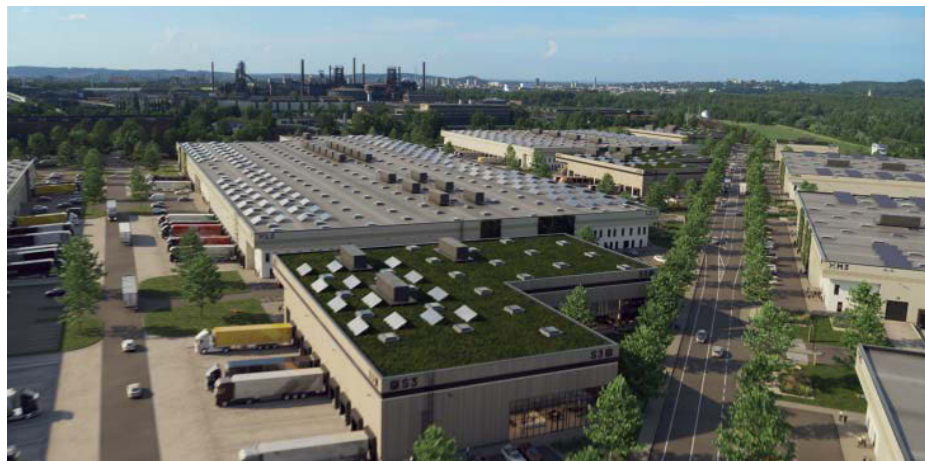
City logistika a skladová logistika, showroomy, výdejny, lehká výroba, R&D i kanceláře budou tvořit novou obchodně-průmyslovou čtvrť P3 Ostrava Central.
